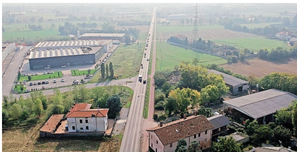
Il tracciato che da Bergamo conduce a Treviglio
